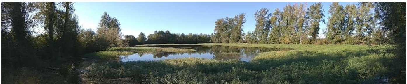
Bassin de rétention de Saubens
