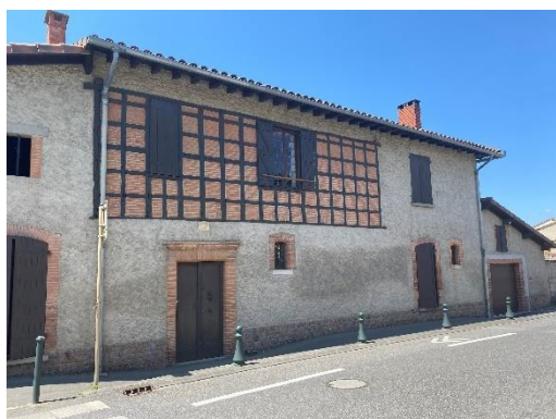
Photo du bâti depuis la rue Clément Ader
